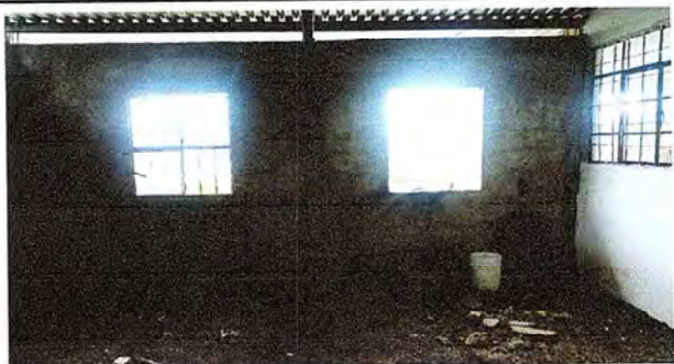
paredes del area de la cocina en remozamiento
