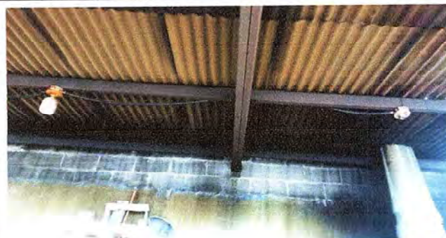
techo del area de cocina en remozamiento
