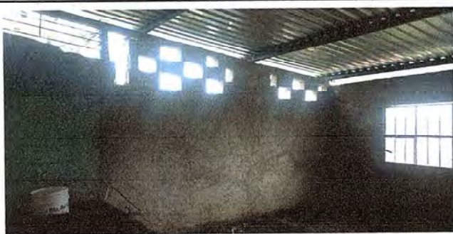
pared del area de cocina en remozamiento
