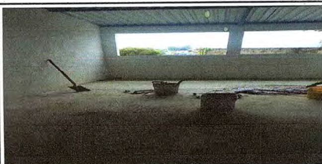
paredes y piso de una de la aulas en remozamiento
