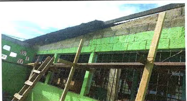
techo de una de las aulas en remozamiento
